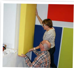
Sture och Karin monterar akustikpaneler vid Radio Vida i Spanien
